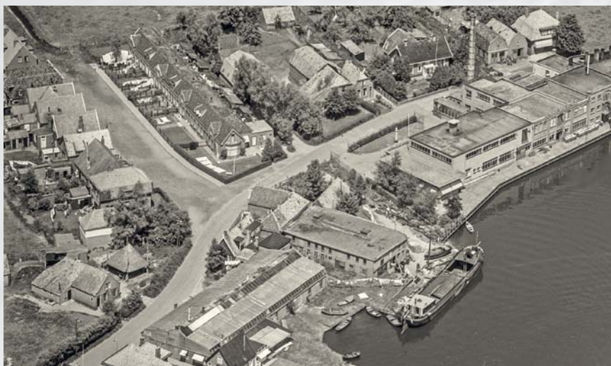
Teerfabriek van firma Jakobs tegenover de Veldweg aan het Meppelerdiep
