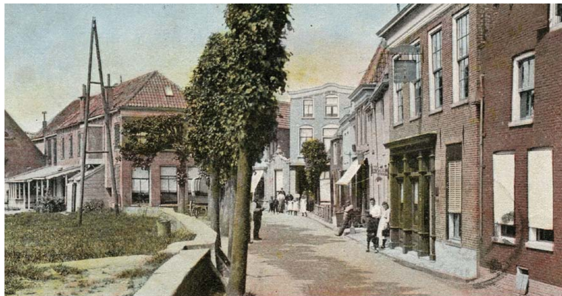
De Stationsweg met duidelijk zichtbaar de waterkeringsmuur
