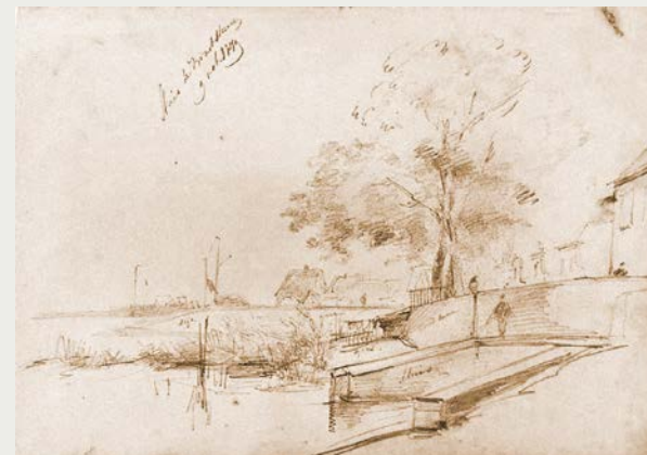
Op de schets staat "Sluis te Zwartsluis 9 oct. 1879". Het is de stroomsluis/duiker in de Hasselderdijk. Rechts de woning van de ir. van Waterstaat.
