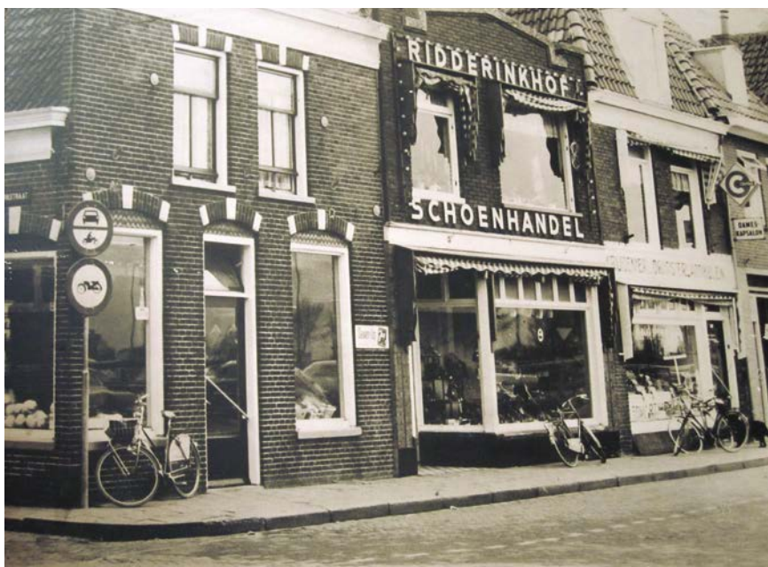
Schoenzaak aan de Stationsweg
