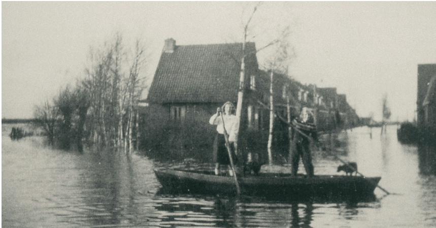
Water in de Berkenlaan door inundatie.
