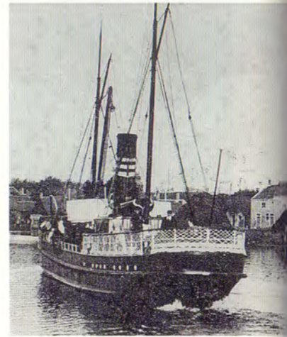
De stoomboot 'Meppel 1' in de Buitenhaven van Zwartsluis, vermoedelijk in 1936. Het belang van de stoomboten was in die tijd reeds sterk afgenomen, vanwege de opkomst van trein, tram en autobus.
