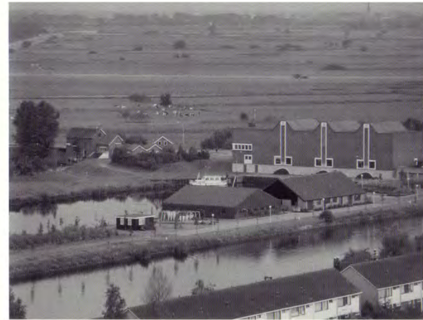
Het supergemaal Zedemuden dat in 1974 in gebruik werd genomen, om een eind te maken aan de overstromingen van het Meppeler Diep, die optraden bij gestremde natuurlijke lozingen op het Zwarte Water. Het gemaal, met een capaciteit van 6750 kubieke meter water per minuut bij een opvoerhoogte van 1.75 meter, was jarenlang het grootste van Europa. Een stroomgebied van 100.000 hectare langs Overijsselse en Drentse rivieren en kanalen was daarmee ontlast. Ook de opvolgers van de in 1836 opgerichte 'Dijkdistricten', anno 1999 opgenomen in de waterschappen 'Wold en Wieden' en 'Groot Salland' gingen bijdragen aan de kosten van het gemaal. Op de achtergrond het in 1917, ten behoeve van de ontwatering van het Staphorsterveld gestichte en in 1992 vervangen gemaal Kostverlorenzijl. De foto werd genomen in 1985.
