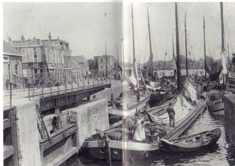
In de Grote Kolksluis.
